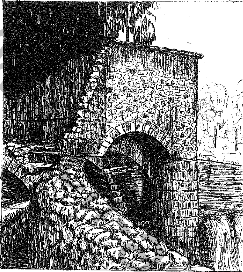
Prise d'eau du canal et son déversoir
